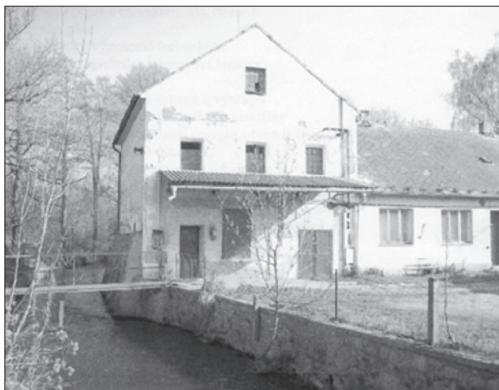
Stav Brokova mlýna před rekonstrukcí, 2012
