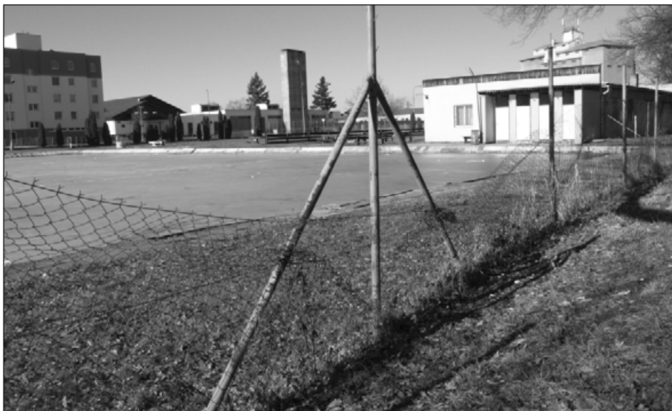
Současný neutěšený stav koupaliště Škorna.
