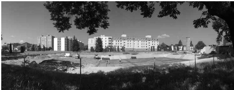
Zmenšení vodní plochy - stavební práce v areálu Škorna (foteno z hráze někdejšího rybníka).
