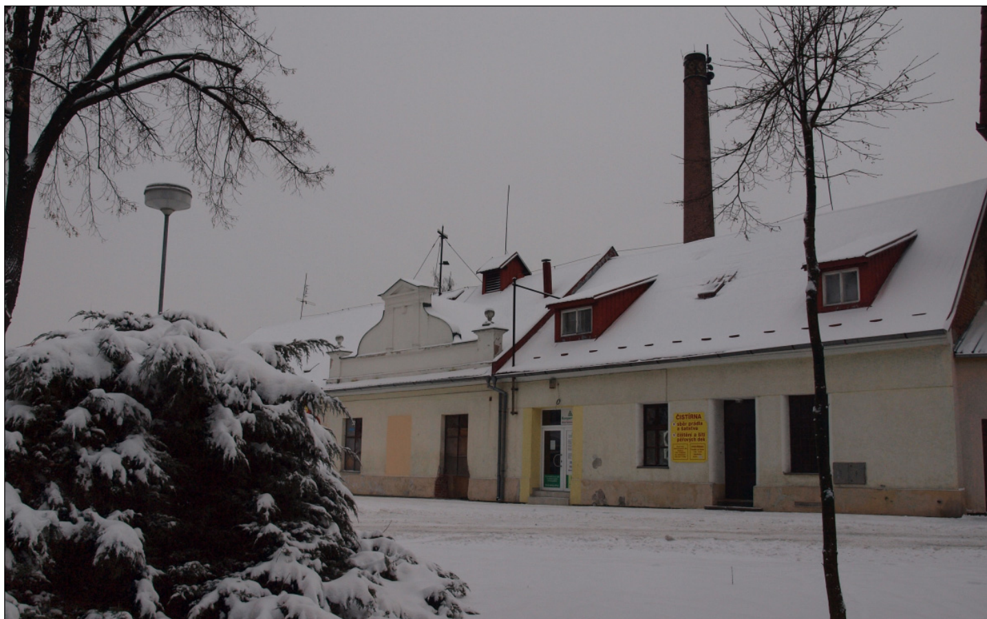
Městská elektrárna ve Vodňanech v lednu 2010
