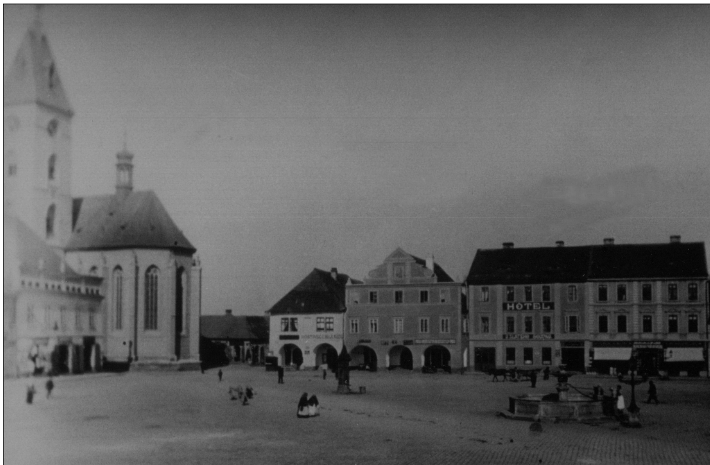
Severní strana vodňanského náměstí – stav kolem roku 1900.
