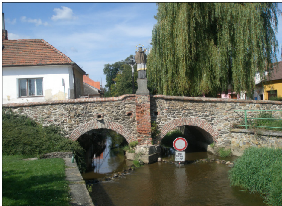
O tom, že Vodňany mají nejen vandaly, ale také šprýmaře, svědčí dopravní značka přenesená z mostu sv. Jana Nepomuckého, který byl opraven za podpory Ministerstva kultury ČR, do Mlýnské náhonu pod mostem.
