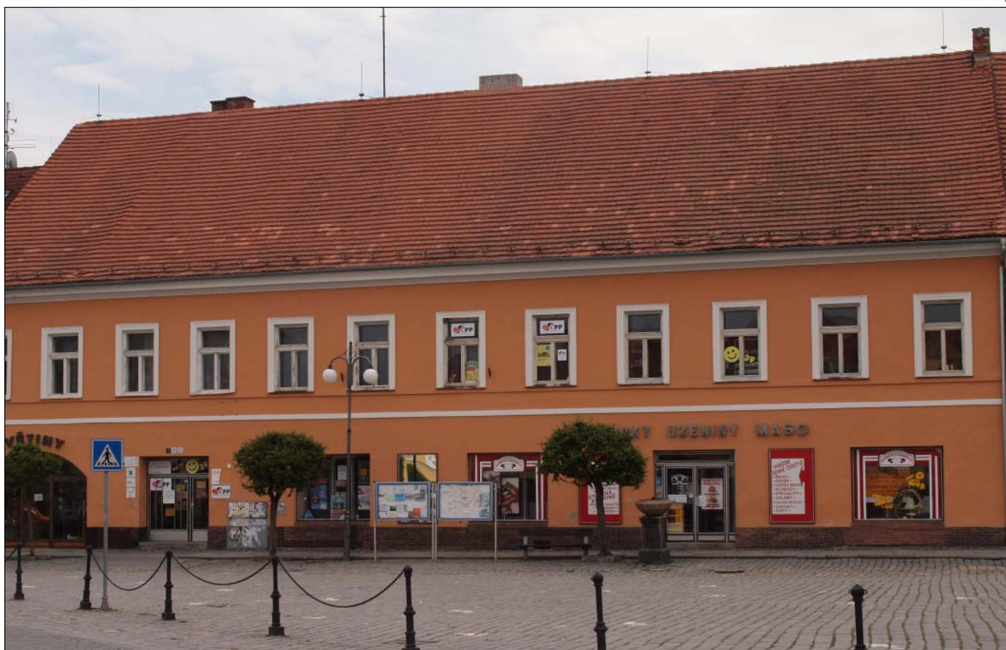
Současný stav domu čp. 10-11.
