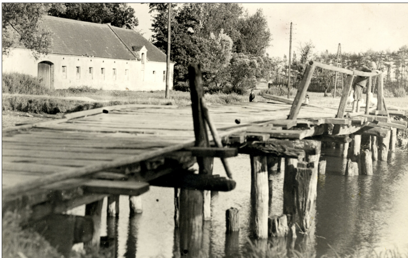
Dřevěný most poblíž Mosteckých mlýna sloužil do poč. 20. let 20. století, poté vznikl současný betonový most během regulace řeky.
