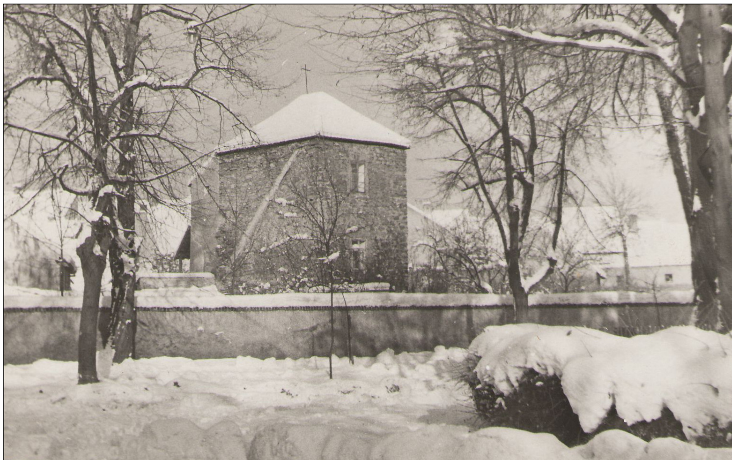
Součástí vodňanského obranného hradebního systému byly také čtvercové bašty z 1. poloviny 15. století, z nichž se do současné doby zachovaly jen tři. Foto: archiv MaG
