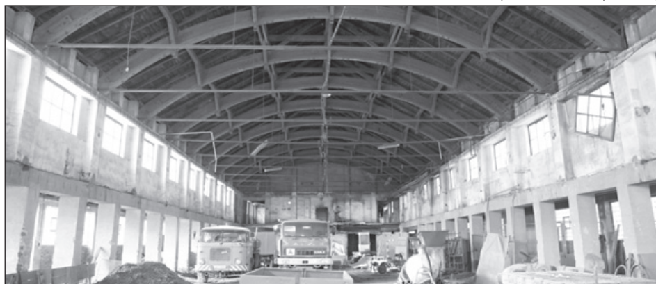
Prostor vnitřní části cihelny, kde bývala vypalovací pec. Krov je tvořen zajímavou dřevěnou segmentovou konstrukcí.
