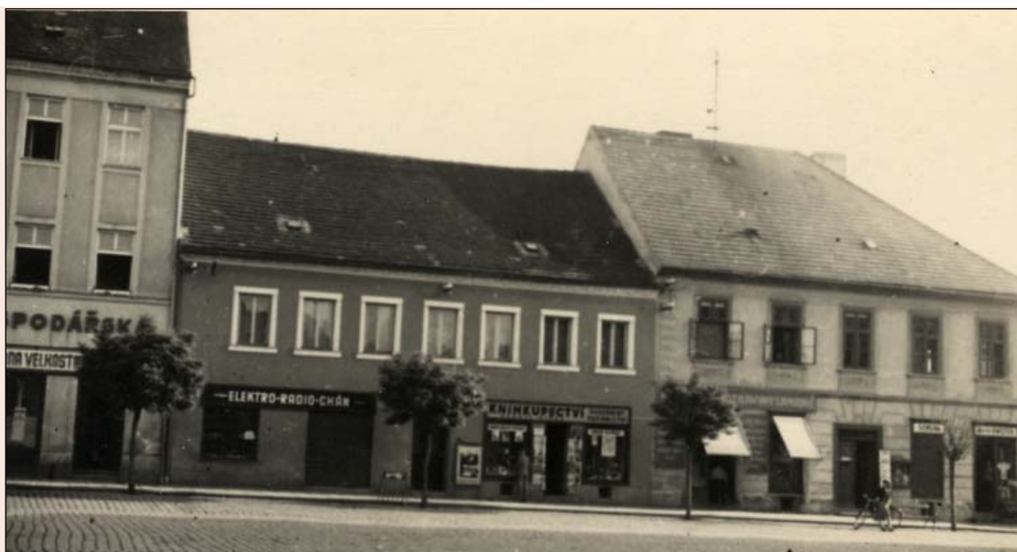
Severní strana náměstí s domy čp. 19-21 ve 40. letech 20. století Archiv MaG Vodňany
